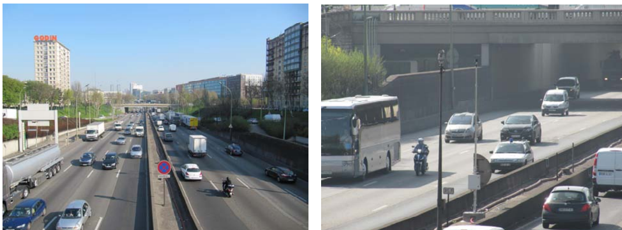
Figure 25 : Station de mesure du bruit au niveau du terre-plein central.
