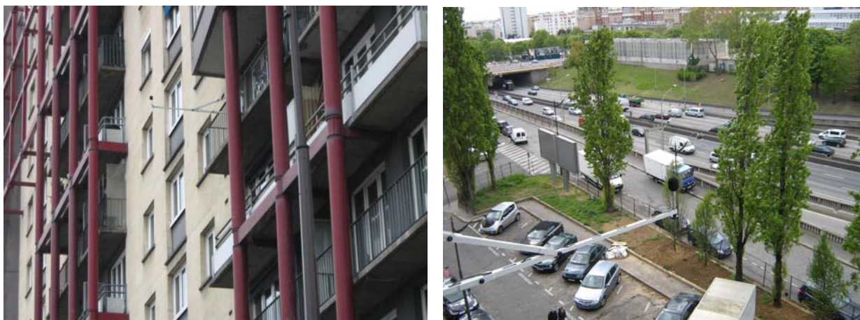
Figure 29 : Station de mesure du bruit en façade de l'immeuble Elie Faure.
